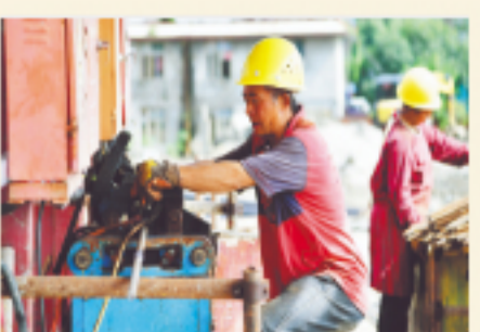
成都国际空港商务区展示中心项目加快建设
