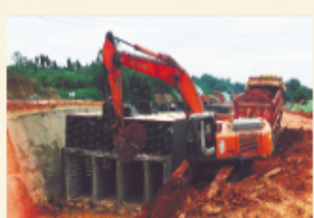
天府国际机场北一线路和综合管廊工程全速推进
