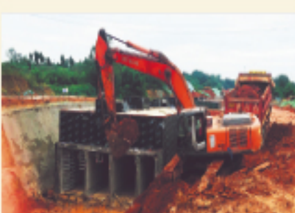
天府国际机场北一跑道和综合管廊工程全速推进
